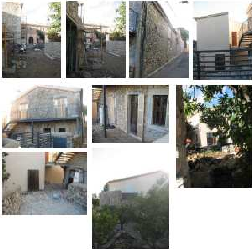
Fotografies realitzades durant la reforma (novembre de 2014)
